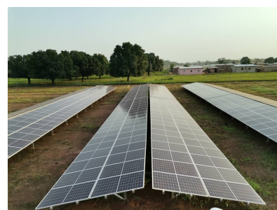
Mali: Ländliche Elektrifizierung
